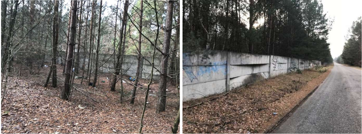
Abbildung 20 und 21: Mauer entlang der Telekomstraße und im Wald
