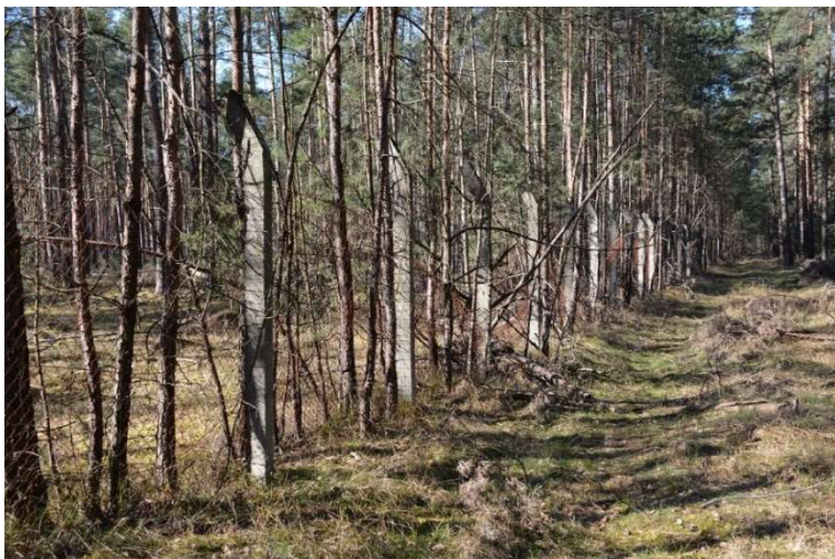
Abbildung 25: Zaun im westlichen Bereich aus Betonpfählen mit Maschendraht, teilweise Stacheldraht
